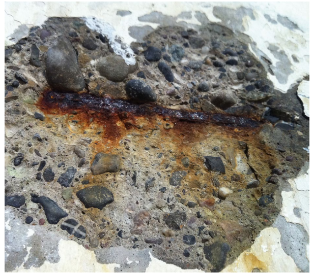
Betonabplatzung infolge Bewehrungskorrosion
