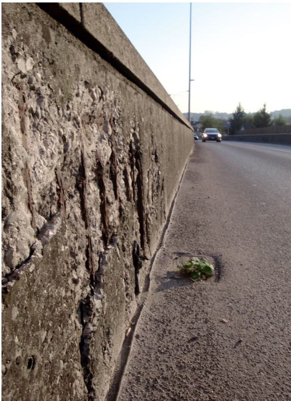
Korrosion infolge Chlorideinwirkung
