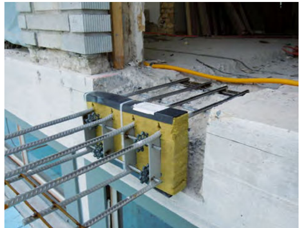
Anschluss an bestehendes Gebäude (mit Niveau-Versatz)
