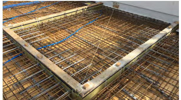
Bauseitige Bewehrung S. 40–42
