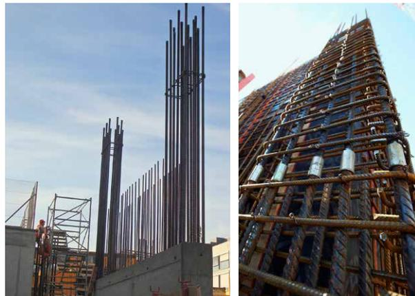
Mur parasismique avec armatures latérales concentrées.
