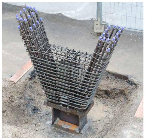
Armature haute résistance Top700 dans les piliers, avec liaisons par filetage BARTEC® TOP.
