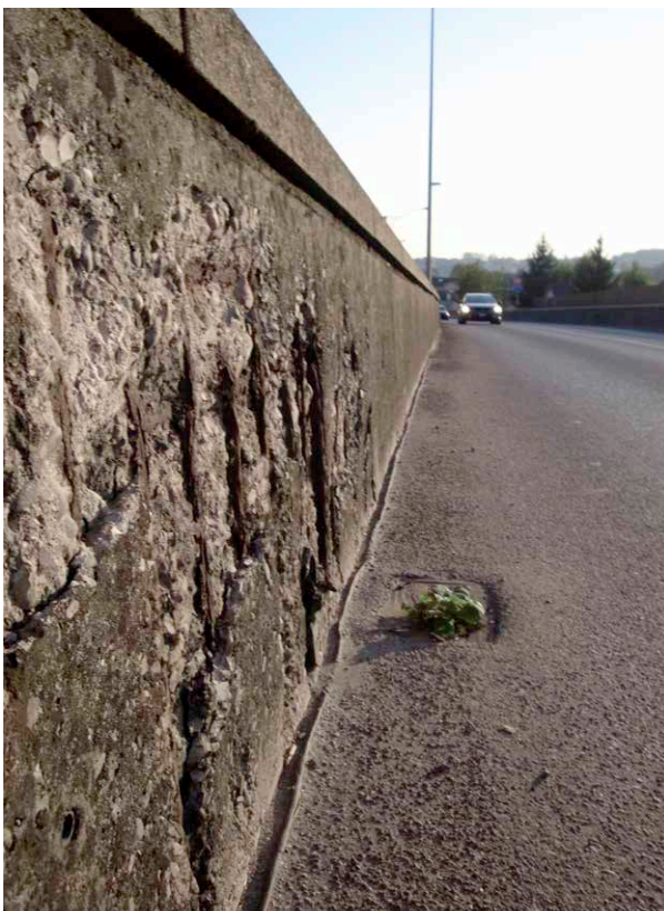
Corrosion due à l'action des chlorures
