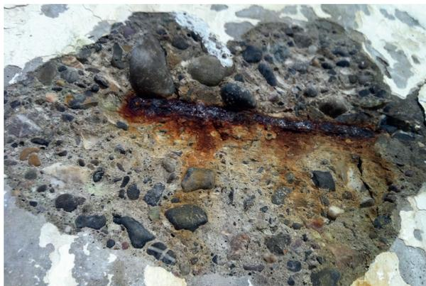
*Eclatement du béton provoqué par la corrosion de l'armature*
