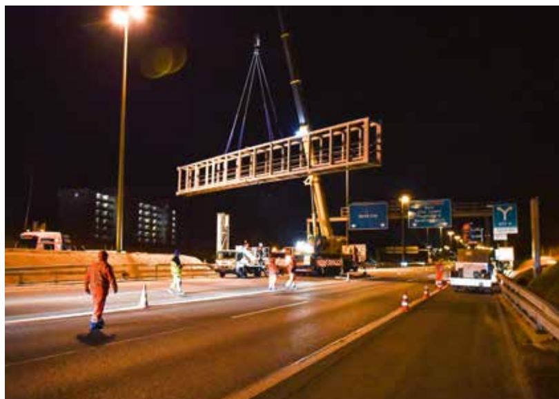
Einheben eines Signalportalträgers in der Nacht. Während 15 Minuten musste die Autobahn A1 hierfür voll gesperrt werden.
