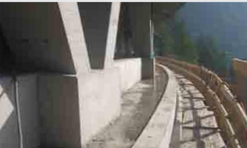
Die Josefgalerie am Simplonpass wurde instandgesetzt und u.a. mit einer Leitmauer versehen. Erfahrungsgemäss finden in Bauteilen im Spritzwasserbereich von Strassengalerien – insbesondere solcher ohne Wintersperre – grosse Aufkonzentrationen von Chloriden aus Tausalzen statt. Um auch dort Bewehrungskorrosion zu vermeiden, wurde die Leitmauer mit Top12 bewehrt (Bügel und strassenseitige Längsbewehrung).
