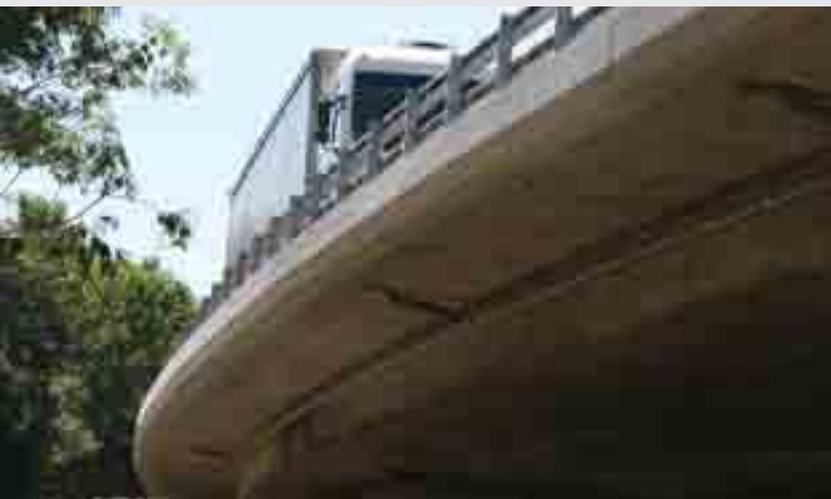
Bei der A1-Verzweigung Härkingen wurden die Überführungsbauwerke umfassend instandgesetzt. Die Konsolköpfe waren infolge Bewehrungskorrosion geschädigt und mussten ersetzt werden. Dank der Verwendung von Top12 werden zukünftige Instandsetzungen und die damit einhergehenden Kosten und Verkehrsbehinderungen vermieden.
