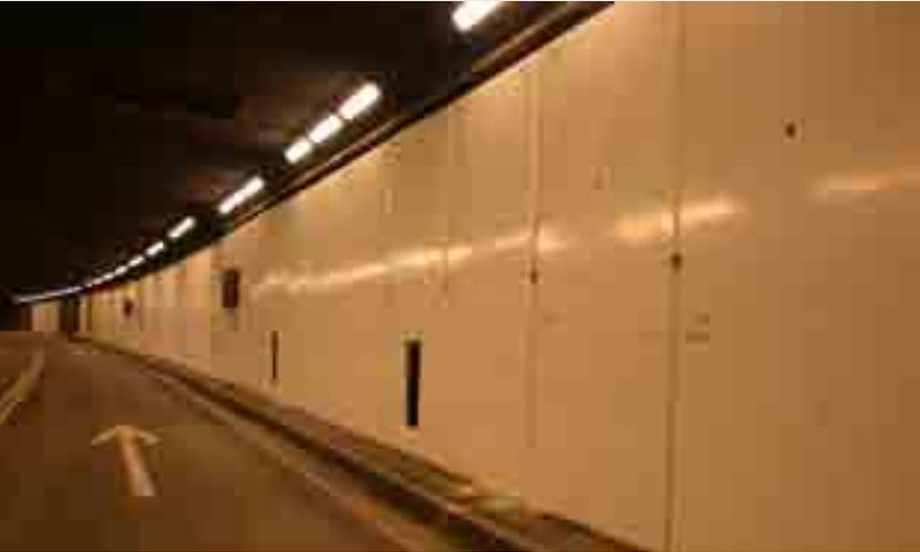
Infolge massiven Chlorideintrags waren die Wandplatten des Gotthardstrassentunnels auf dem ersten Kilometer vom Tunnelportal Süd in einem schlechten Zustand und mussten ersetzt werden. Die vorgefertigten, 70 mm dicken Betonplatten sind mit Top12 sowie im Einfahrtsbereich mit einem nicht-rostenden Stahl 1.4362 bewehrt. Aufgrund der geometrischen Einschränkung resultierte eine strassenseitige Bewehrungsüberdeckung von 30 mm.
