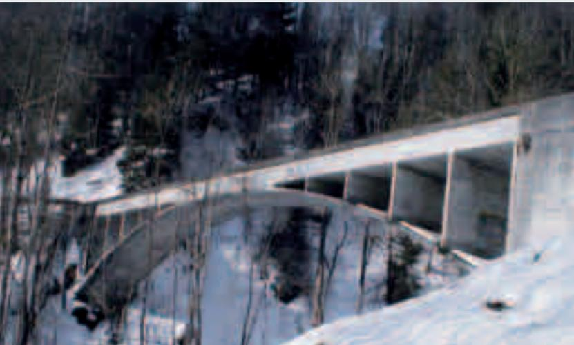
Der chloridbelastete Beton der von Robert Maillart projektierten Traubachbrücke wurde bis auf die bestehende Bewehrung abgetragen. Die neue Vorbetonierung wurde mit Top12 bewehrt. Eine Beschichtung als Korrosionsschutz wäre zu wenig robust gewesen. Mit Top12 reichen 30 mm Bewehrungsüberdeckung, um Instandsetzungen während 50 Jahren zu vermeiden und die lichte Weite der Fahrbahn nicht einzuschränken.
