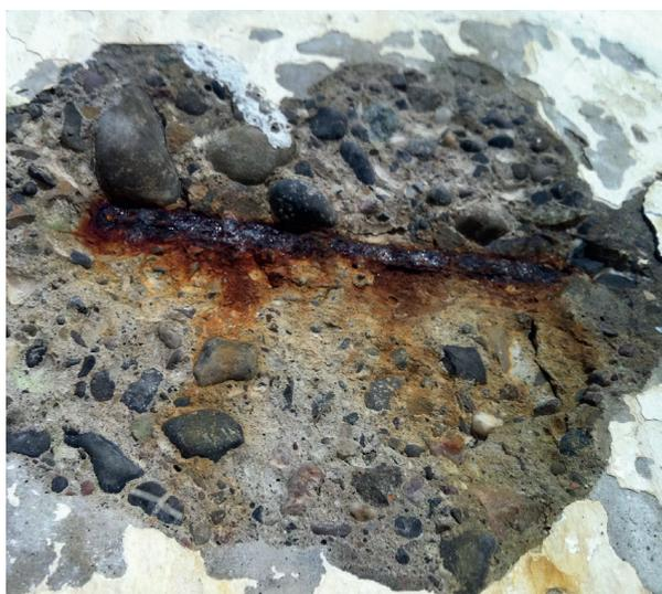
*Eclatement du béton suite à la corrosion de l'armature*
