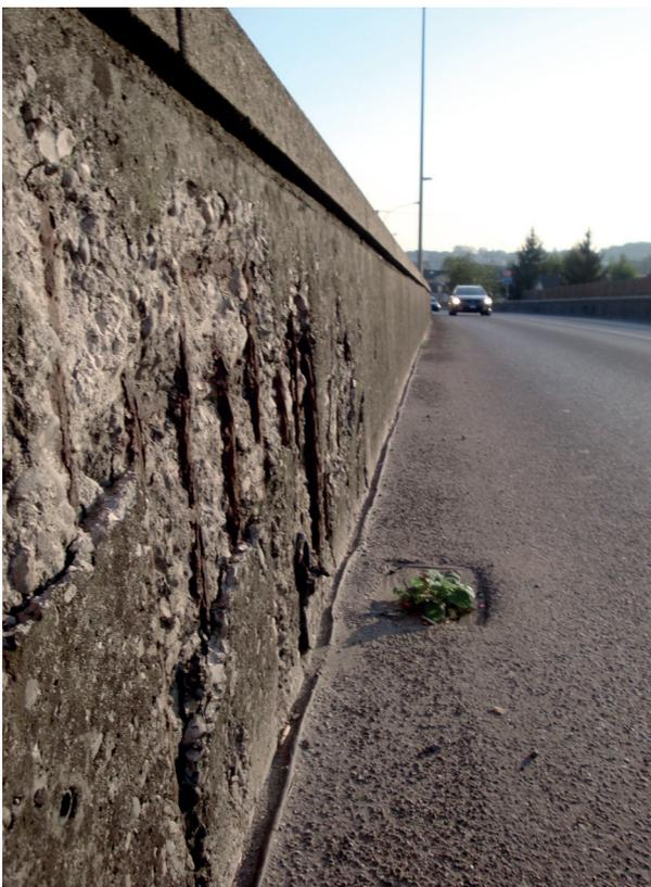
Corrosion due à l'action des chlorures
