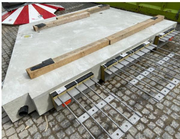
Le raccordement de dalles de balcons préfabriqués en porte-à-faux sur les dalles préexistantes nécessitait des consoles isolantes à hautes performances.
