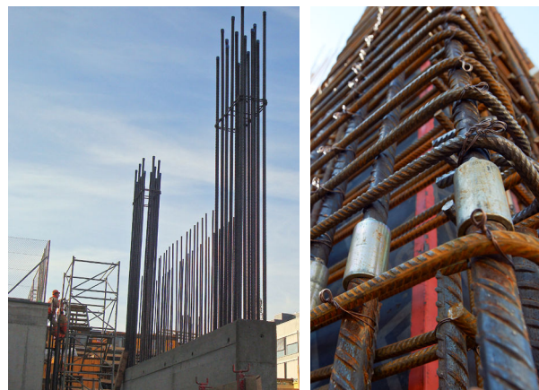
Mur parasismique avec armatures latérales concentrées.
