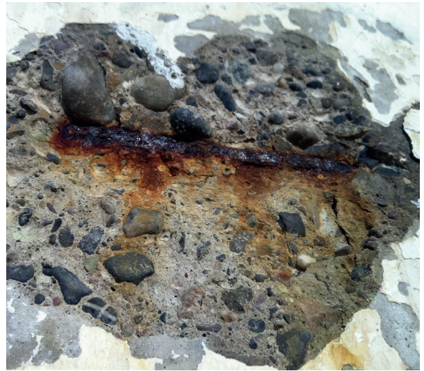
Betonabplatzung infolge Bewehrungskorrosion
