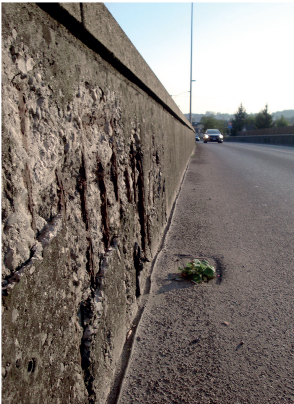
Korrosion infolge Chlorideinwirkung
