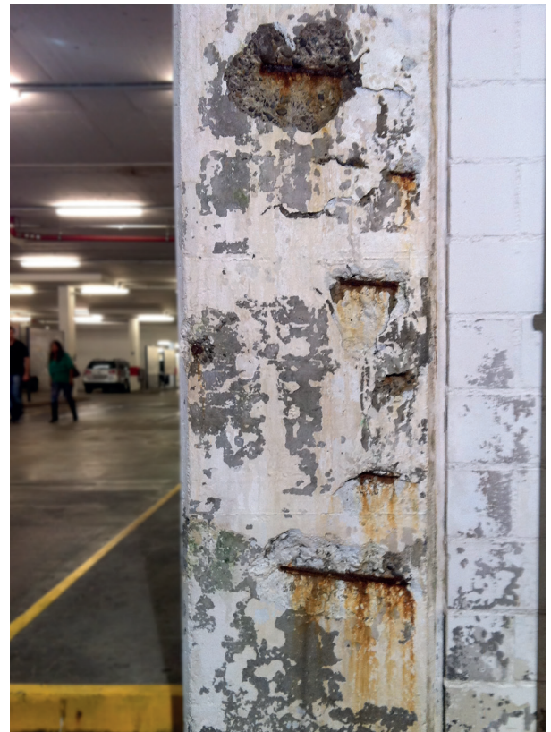
Korrosion infolge Karbonatisierung des Betons
