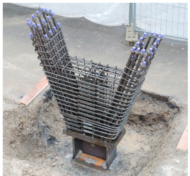
Hochfeste Top700 Stützenbewehrung mit BARTEC® TOP Schraubverbindungen
