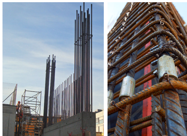
Erdbebenwand mit konzentrierter Randbewehrung
