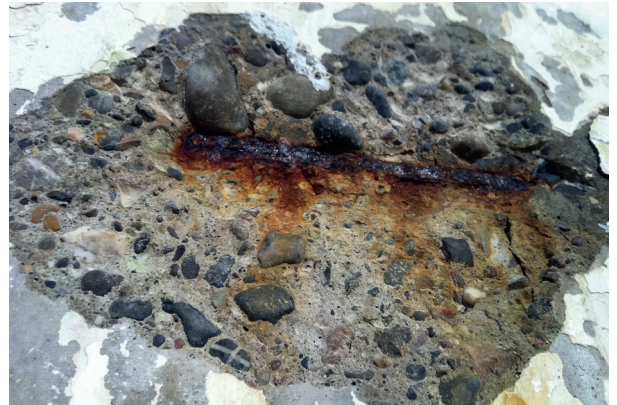
Betonabplatzung infolge Bewehrungskorrosion
