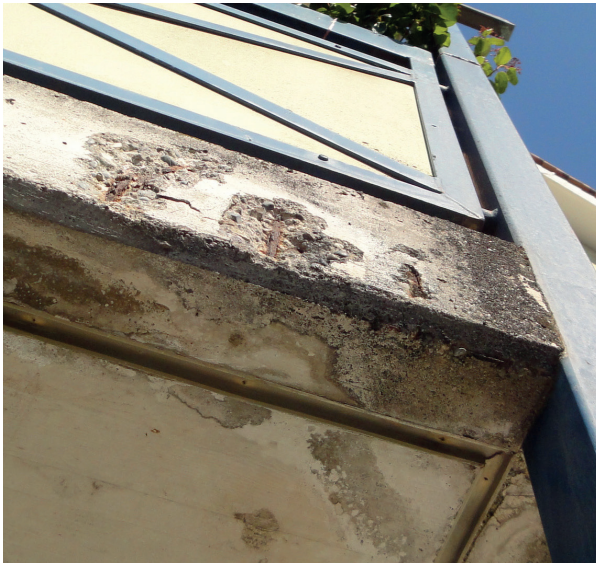
Punktuell zu geringe Bewehrungsüberdeckung
