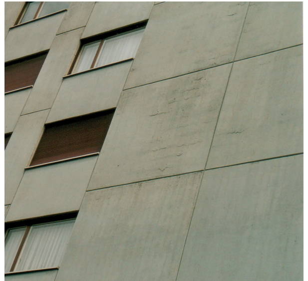
Generell zu geringe Bewehrungsüberdeckung
