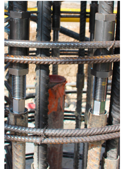
LER: Verbindung von 2 Pfahlarmierungskörben
