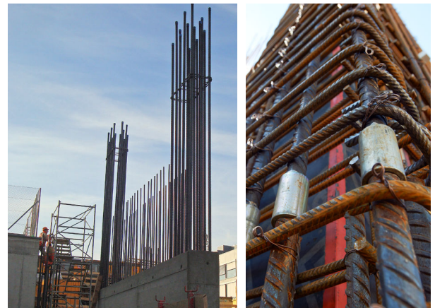
Erdbebenwand mit konzentrierter Randbewehrung
