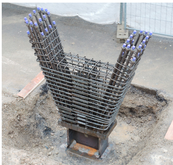
Hochfeste Top700 Stützenbewehrung mit BARTEC® TOP Schraubverbindungen
