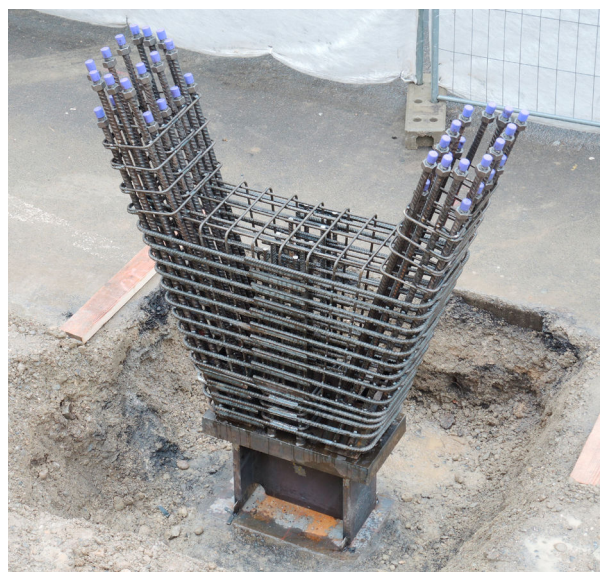
Hochfeste Top700 Stützenbewehrung mit BARTEC® TOP Schraubverbindungen
