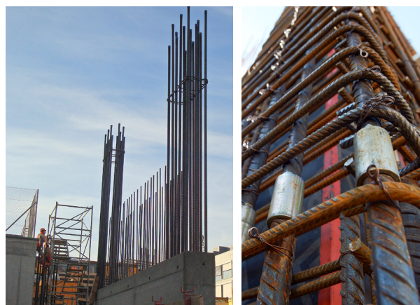
Erdbebenwand mit konzentrierter Randbewehrung
