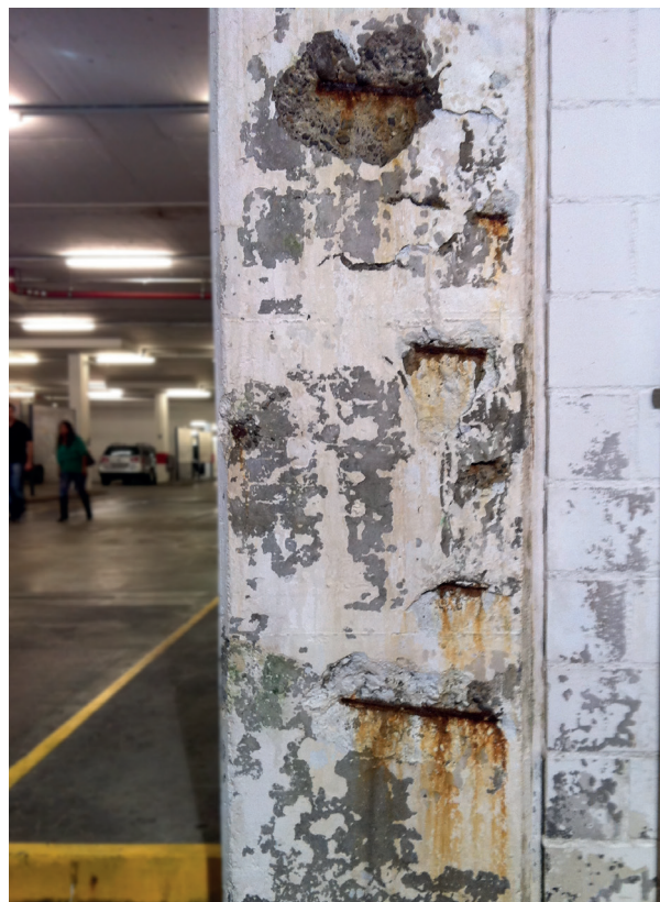
Corrosion due à la carbonatation du béton
