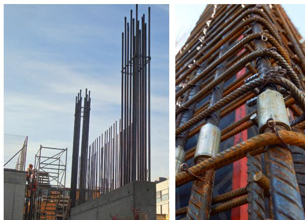
Mur parasismique avec armatures latérales concentrées.
