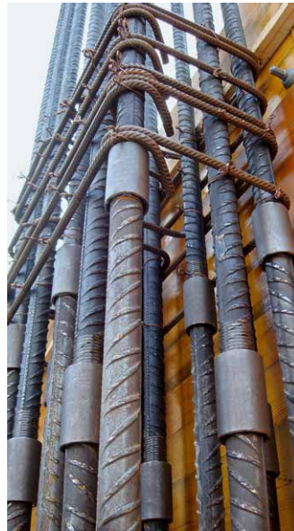
Erdbebenwand mit konzentrierter Randbewehrung.
