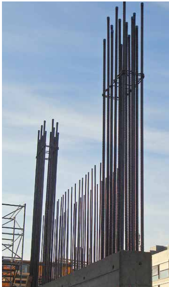
Erdbebenwand mit konzentrierter Randbewehrung.
