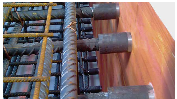
BARTEC® Schraubverbindungen in der Deckelplatte Halle Ost.
