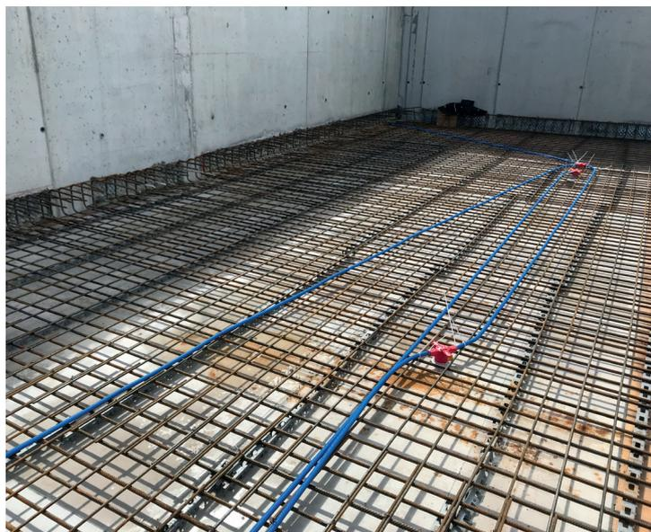
*Die Zwischendecken mit Erdbebenanbindung wurden mithilfe von PYRATOP® nachträglich eingehängt.*
