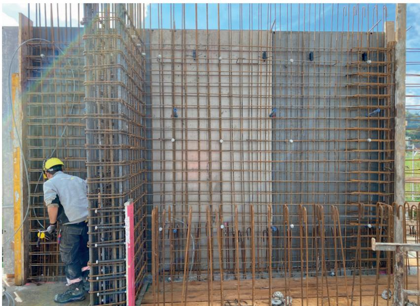
Querschotte und Endauflager der Brüstung mit eingebautem PYRABAR®.
