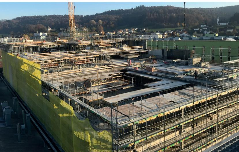
Die Emil Frey Gruppe baut in Safenwil AG ein achtgeschossiges Gebäude für die Inspektion der Neuwagen, bevor diese ausgeliefert werden. Der Ingenieur hat sich beim Neubau wegen stark wirkender, teilweise biaxialer Querkräfte in den Arbeitsfugen für den Einsatz von PYRAX®-Produkten von Debrunner Acifer Bewehrungen entschieden.
