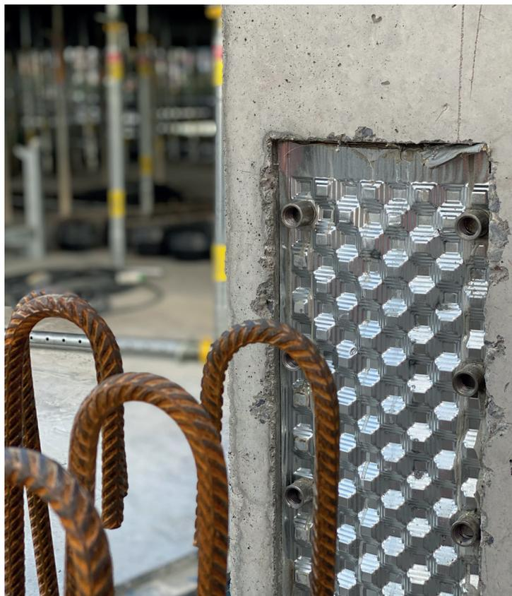
*Appui d'extrémité du parapet sur la cloison transversale avec boîte PYRABAR®.*
