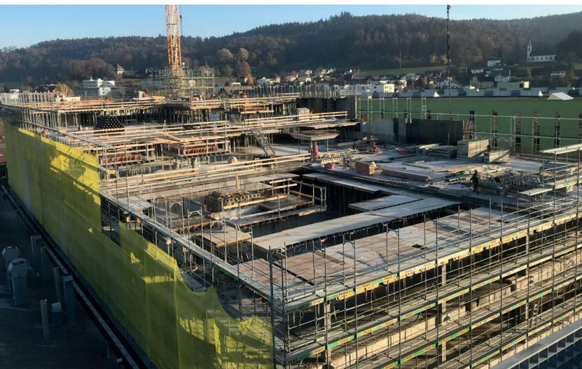
Le Groupe Emil Frey construit un bâtiment de huit étages à Safenwil (AG) pour l'inspection des véhicules neufs avant livraison. Pour ce nouveau bâtiment, l'ingénieur a choisi les produits PYRAX® de Debrunner Acifer Bewehrungen en raison des puissantes forces transversales – en partie biaxiales – qui s'exercent dans les joints de reprise.
