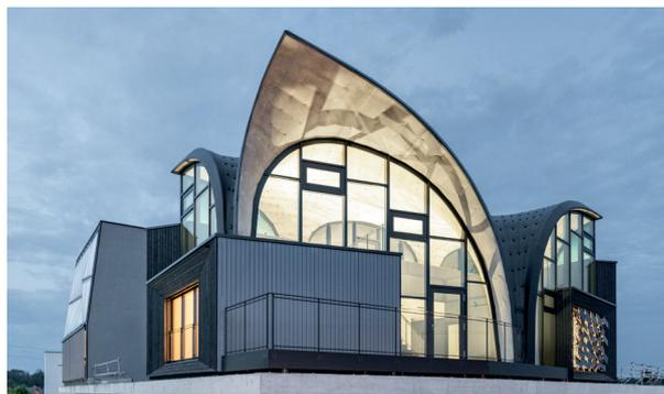
*Cette méthode de construction permet d'obtenir des éléments en béton de faible épaisseur et des formes bombées complexes.*
