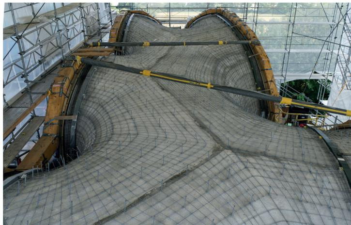
*D'un diamètre de seulement 6 mm, les barres d'acier d'armature B500 galvanisé PREZINC 500® se plient aisément à la main.*
