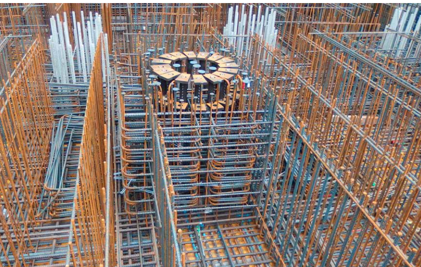
Oberster Bereich eines Bohrpfahles mit Endverankerungsplatten und Schubbewehrung.
