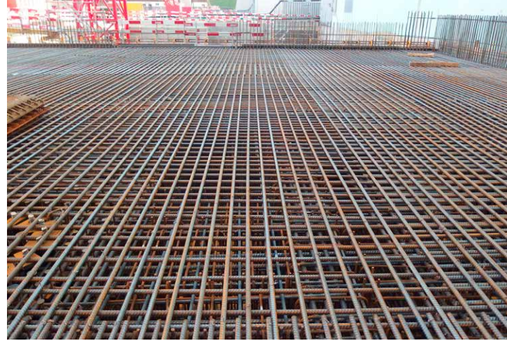
Fundamentplatte Aktivilagerhalle Nord: Zwölf Lagen Bewehrungsstahl sind fertig verlegt.
