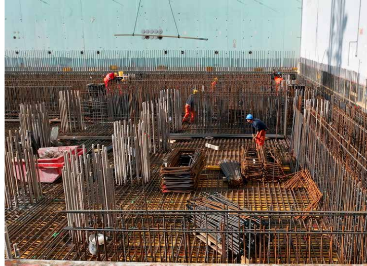
Fundament Aktivlagerhalle Nord: verlegen der unteren Bewehrungslagen, vertikale Pfahlbewehrung.
