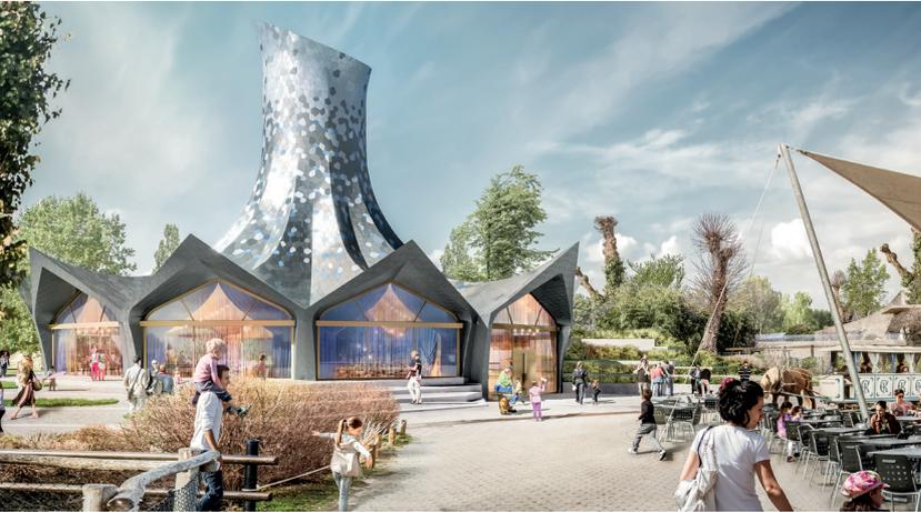
**Die neue multifunktionelle Eventlocation im Knies Kinderzoo Rapperswil erinnert optisch an einen Zauberhut. Die Dachkonstruktion aus Holz ruht auf einem zwölfseitigen Stahlbetonfundament. Der Zugring, der die Spreizkräfte des gewaltigen Dachs absorbiert, ist mit BARTEC® LER Schraubverbindungen von Debrunner Acifer geschlossen worden.**
