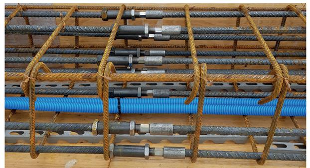
*Mit den BARTEC® LER Schraubverbindungen mit Distanzausgleich lassen sich Toleranzen aus der Biegerei und Verlege-Ungenauigkeiten korrigieren.*
