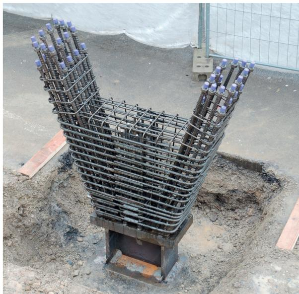
Höherfeste Top700 Stützenbewehrung mit BARTEC® TOP Schraubverbindungen.
