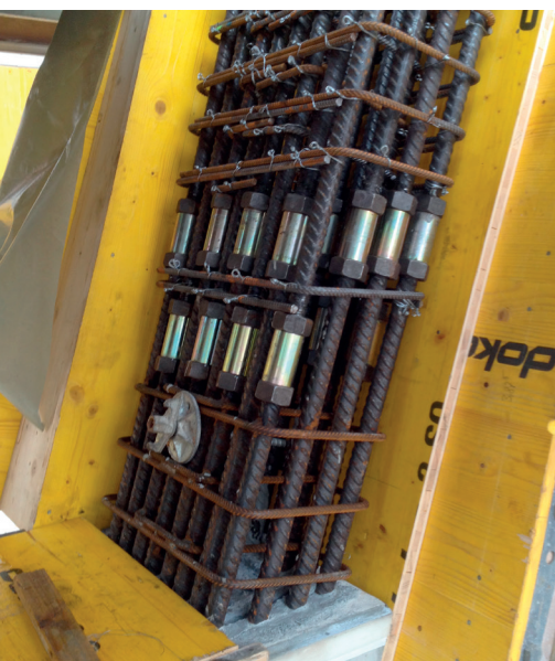
Haute qualité de béton apparent malgré une section d'élément réduite.
