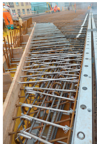
Acier d'armature inoxydable Top12 avec BARTEC®.
