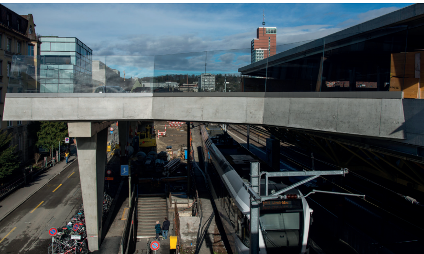
La nouvelle rampe d'accès à 2 voies du parking à étages de la gare de Winterthur.
