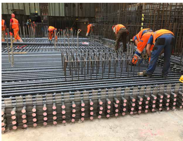
Le radier final comporte par endroits 22 couches d'armatures et une épaisseur de 2,5 m.
