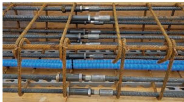
*Les liaisons d'armatures par filetage BARTEC® LER à écartement réglable permettent de compenser les tolérances de cintrage et les imprécisions de pose.*
