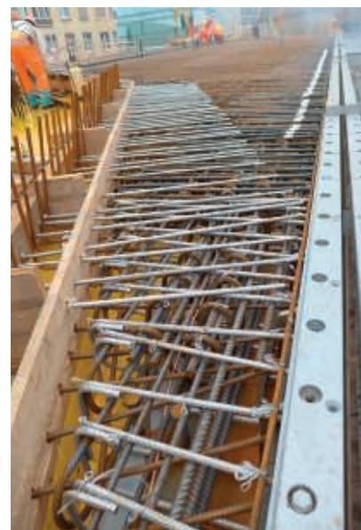
*Acier d'armature inoxydable Top12 avec BARTEC®.*
