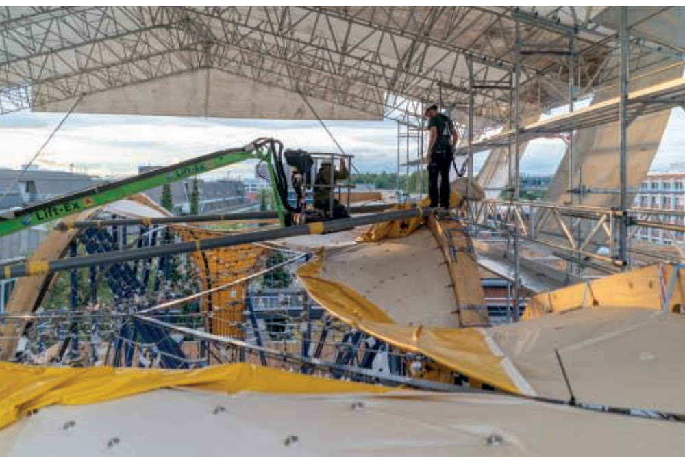
Une bâche en textile polymère posée sur le treillis fait office de coffrage.
