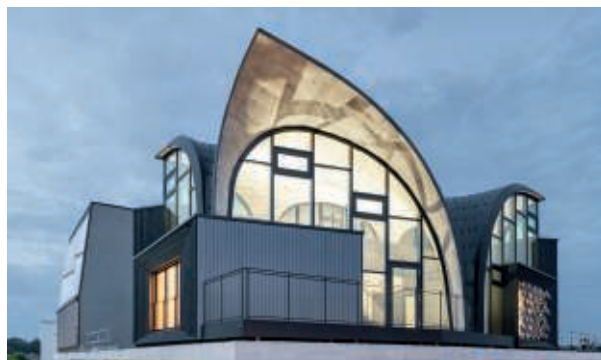
Cette méthode de construction permet d'obtenir des éléments en béton de faible épaisseur et des formes bombées complexes. © ROK Architekten
