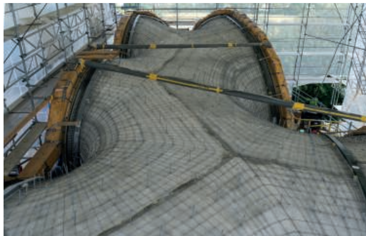
D'un diamètre de seulement 6 mm, les barres d'acier d'armature B500 galvanisé PREZINC 500® se plient aisément à la main. © ROK Architekten
