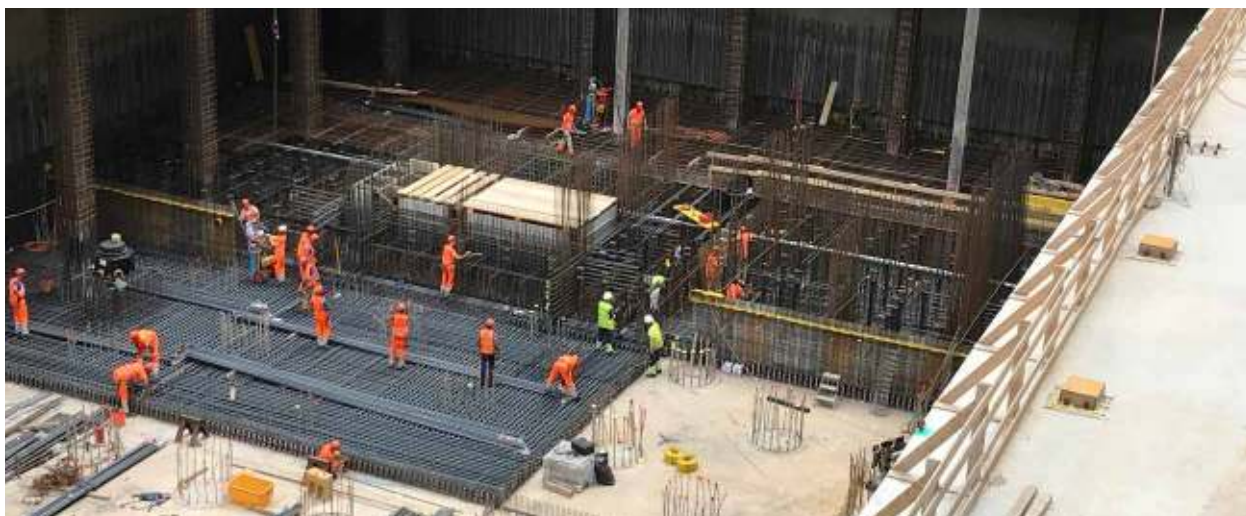
La tour Bau 2 demandera au total 13 000 t d'acier d'armature de Debrunner Acifer AG Bewehrungen.
