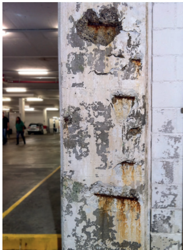
Corrosion due à la carbonatation du béton
