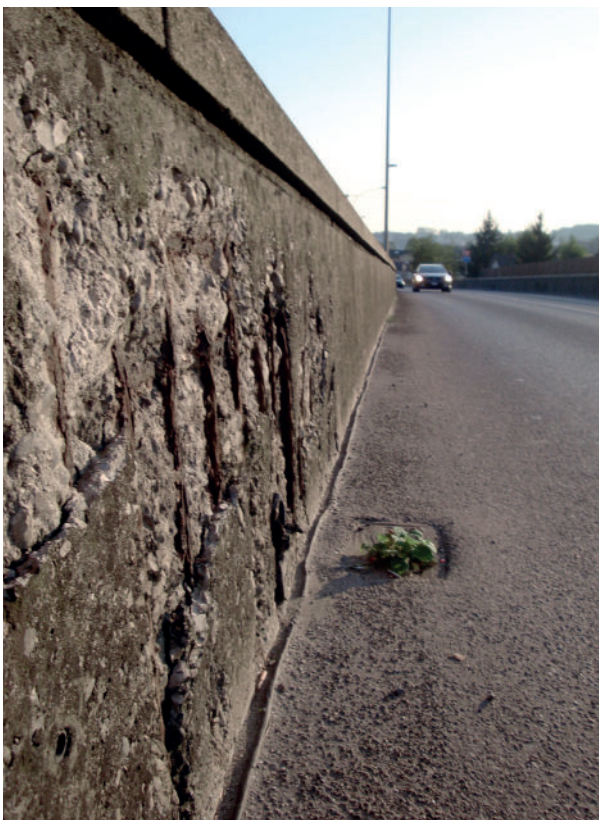
Corrosion due à l'action des chlorures
