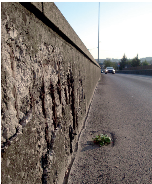
Corrosione dovuta all'azione del cloruro
