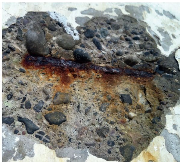
Distacco del calcestruzzo dovuto alla corrosione dell'armatura
