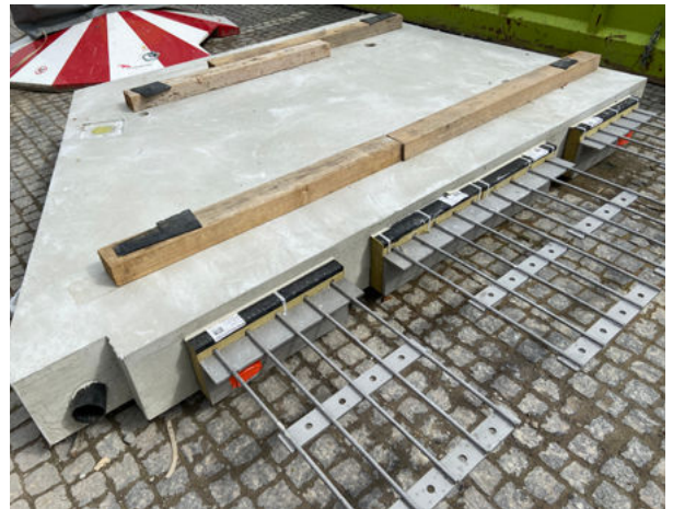
Die vorfabrizierten und auskragenden Balkonplatten forderten starke Kragplattenanschlüsse für die Montage am Bestand.
