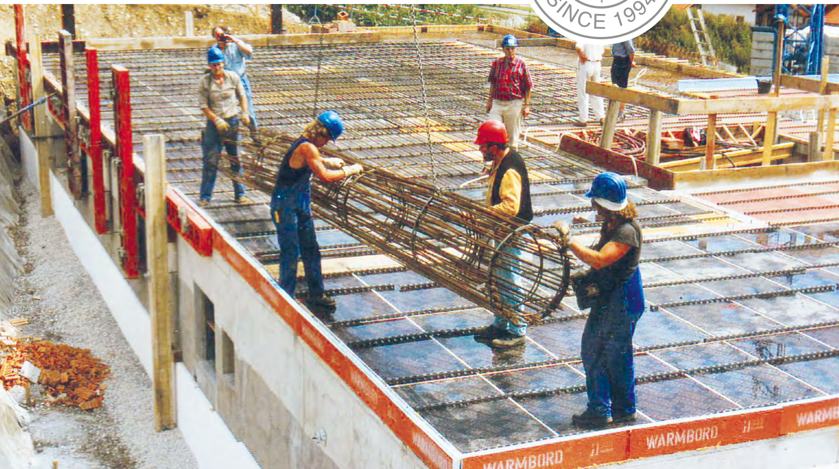
Erste BAMTEC® Baustelle – Oy-Mittelberg im Allgäu, Deutschland
