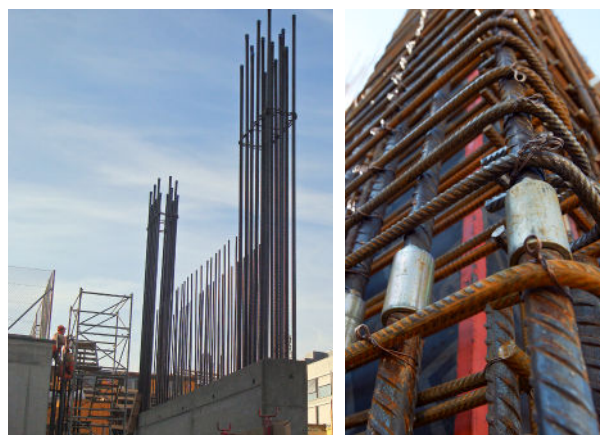
Erdbebenwand mit konzentrierter Randbewehrung
