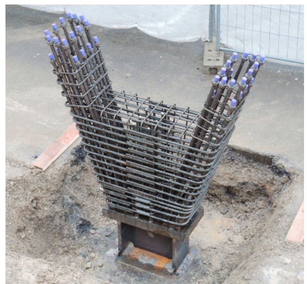
Hochfeste Top700 Stützenbewehrung mit BARTEC® TOP Schraubverbindungen
