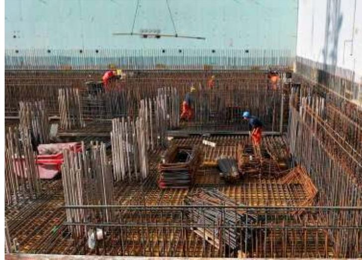
*Fundament Aktivlagerhalle Nord: verlegen der unteren Bewehrungslagen, vertikale Pfahlbewehrung.*
