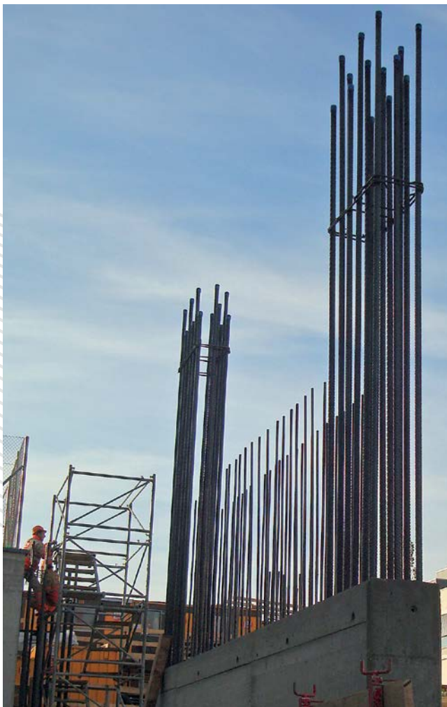
Erdbebenwand mit konzentrierter Randbewehrung
