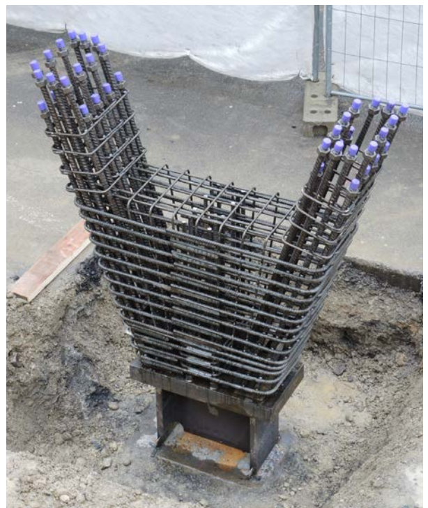
Hochfeste Top700-Stützenbewehrung mit BARTEC® TOP-Schraubverbindungen
