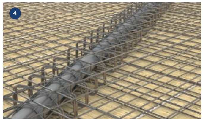
4 Die dritte und vierte Bewehrungslage über die DURA® Boxen verlegen.
