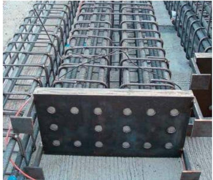
BARTEC® Spezialplatte CT als Mehrfach-Endverankerung.
