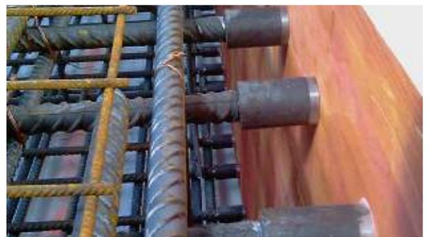
BARTEC® Schraubverbindungen in der Deckelplatte Halle Ost.
