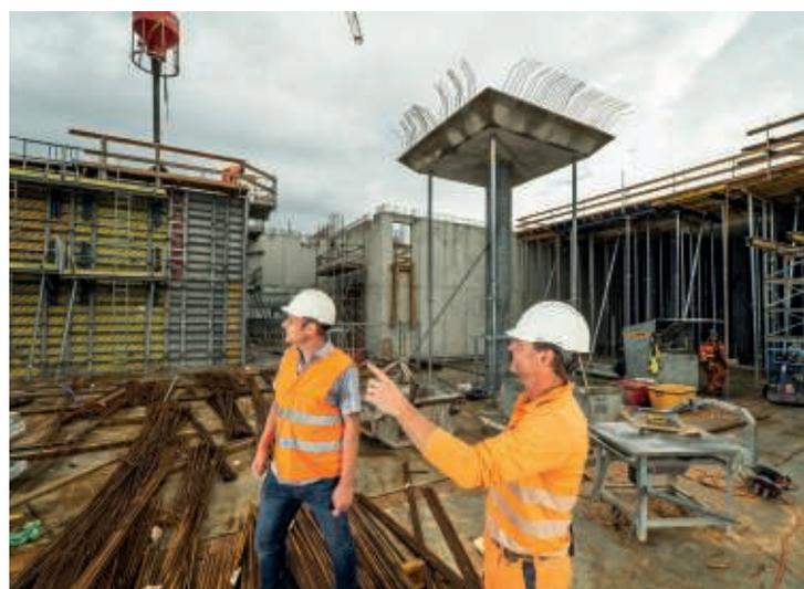
*Bauführer Joel Gwerder (links) und Polier Beat Erni mit den 6,5 m hohen geschalteten und betonierten Wänden im Hintergrund.*
