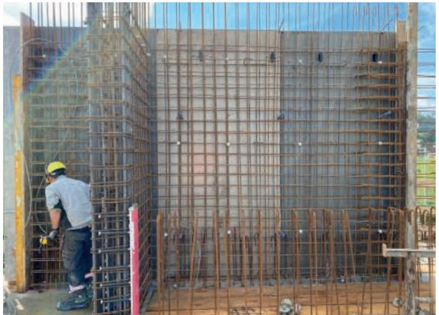
Querschotte und Endauflager der Brüstung mit eingebautem PYRABAR®.
