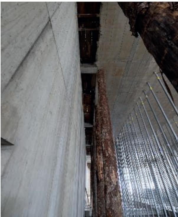
Steigzone mit Untersicht der Querschotten: Nur eine objektspezifische Spezialanfertigung eines PYRABAR®-Anschlusses wurde den extrem hohen Querkräften bei der Anbindung an die Querschotten gerecht.
