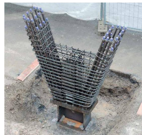
Hochfeste Top700 Stützenbewehrung mit BARTEC® TOP Schraubverbindungen
