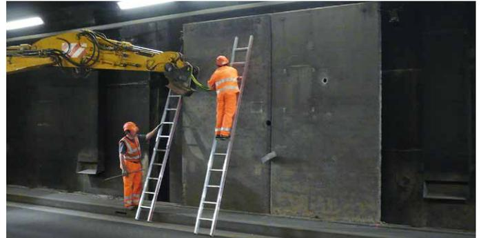
Demontage der schadhaften Platten. Diese können infolge der porösen Oberfläche nicht mehr mit dem Vakuumgreifer gehalten werden.
