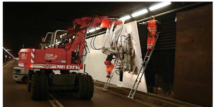
Vakuum-Gerät für die Montage der neuen Platten.
