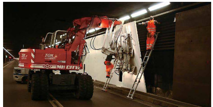
Vakuum-Gerät für die Montage der neuen Platten.
