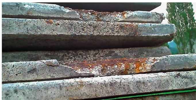
Schadhafte Wandplatten infolge Bewehrungskorrosion und Betonabplatzungen.
