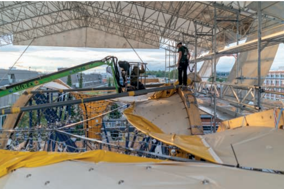
Die textile Polymer-Plane wird als Schalung aufgelegt. © Block Research Group, ETH Zurich | Photo by Juney Lee
