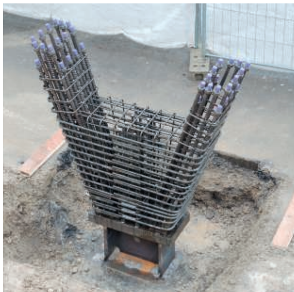
Höchste Top700 Stützenbewehrung mit BARTEC® TOP Schraubverbindungen.
