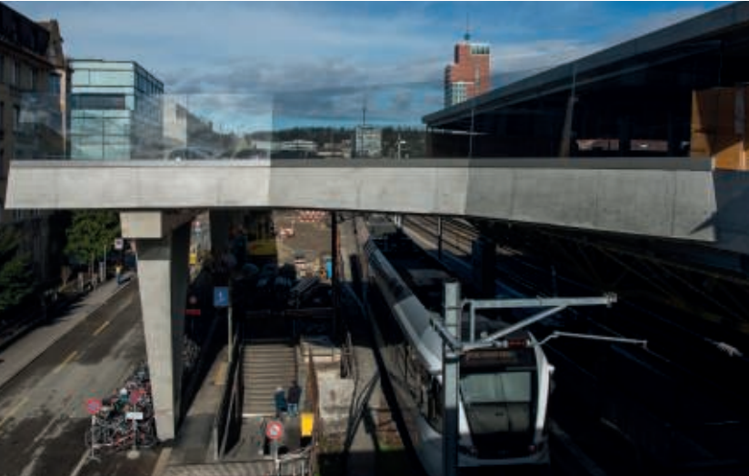
Die neue doppelspurige Erschliessungsrampe des Bahnhof-Parkhauses Winterthur.
