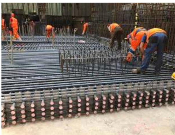
Die finale Bodenplatte besteht teilweise aus 22 Bewehrungslagen und misst eine Stärke von 2.5 m.
