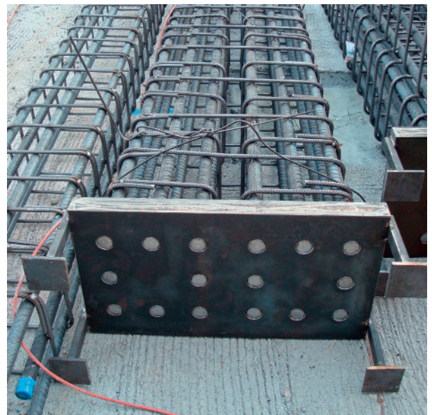
BARTEC® Spezialplatte CT als Mehrfach-Endverankerung.
