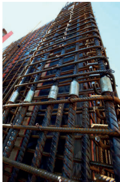
Erdbebenwand mit konzentrierter Randbewehrung.
