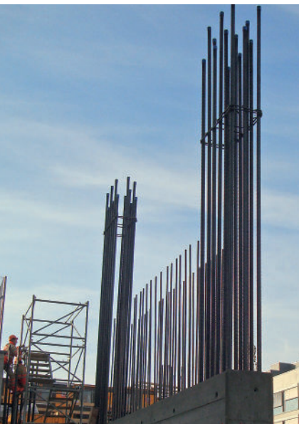
Erdbebenwand mit konzentrierter Randbewehrung.
