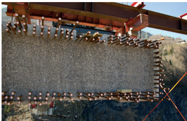
Der Bogen wurde im Scheitelbereich als Vollquerschnitt ausgeführt.
