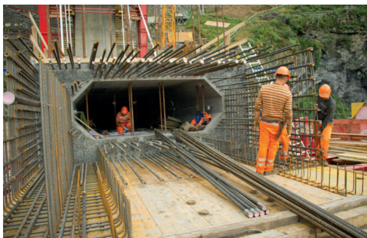
Gegen den Kämpfer hin ist der Bogen ein Hohlkasten.
