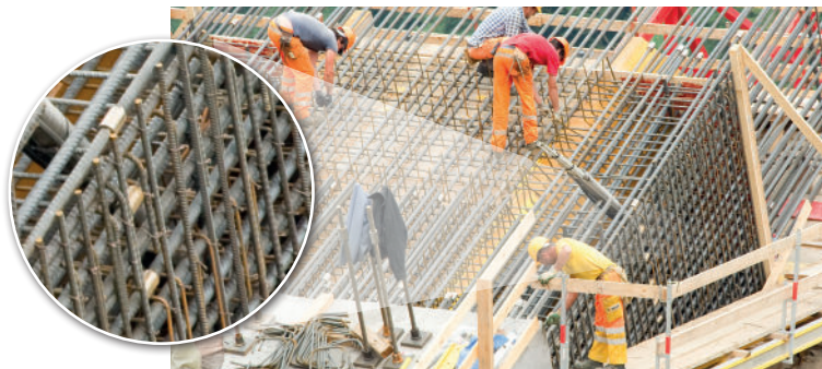
Dank der kompakten Abmessungen passen die BARTEC® Kupplungen selbst zwischen dichte Bewehrungen.
