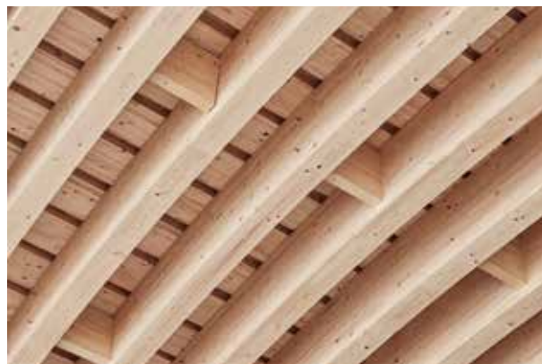
Untersicht mit Dachbinder, Kipphalterungen und Sekundärtragwerk.
