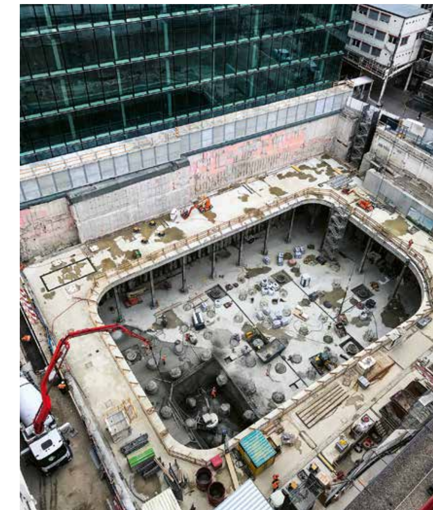
Die Spiessplatte zur Abstützung der Baugrubenwand wird als Decke über das 3. Untergeschoss in das endgültige Hochhaus-Tragwerk integriert.
