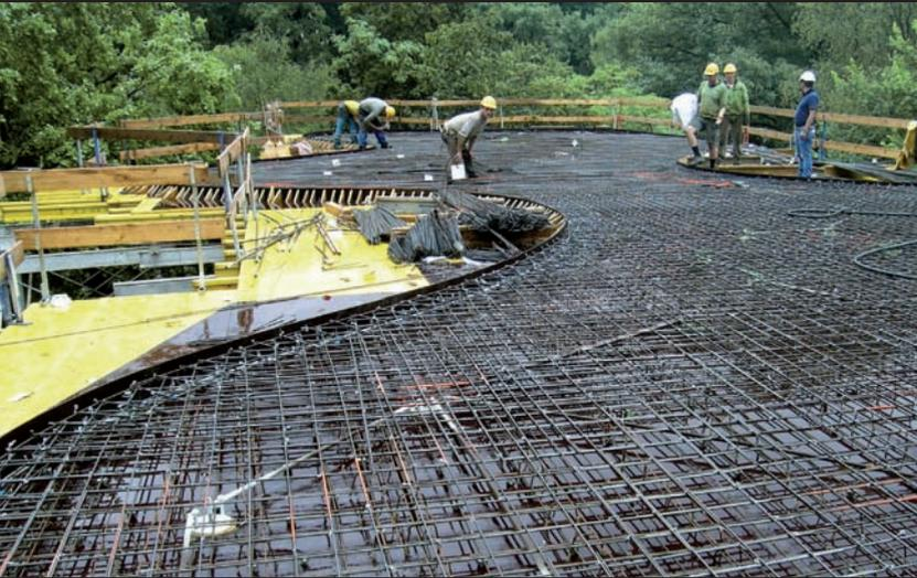
Im Bois-de-la-Bâtie wurden zwei neue Volieren gebaut, um die Vögel des Parks im Falle einer Vogelgrippe zu beherbergen. Die Volieren verschmelzen durch ihre die Bäume imitierenden Stützen, den quasi transparenten Gittern und der Feinheit des Daches mit der Umgebung. Aufgrund der Verwendung des Betonstahl Top12 konnte die Bewehrungsüberdeckung auf der bewitterten Seite der Betonplatte (Bedachung) auf 20 mm reduziert werden.
