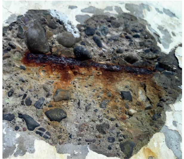
Betonabplatzung infolge Bewehrungskorrosion
